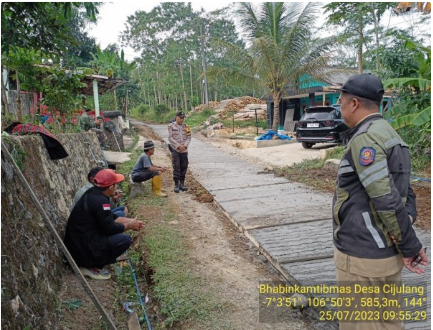
Aipda Sudiro Monitoring Pembangunan MCK di Desa
