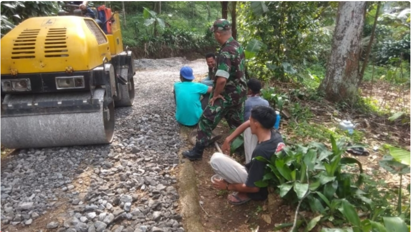
Babinsa Desa Pangkalan Monitoring Pembangunan Infrastruktur
