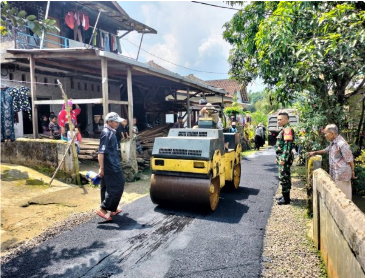
Serda Suherlan Giat Monitoring Perbaikan Jalan di Bojonglongok Kecamatan Parakansalak
